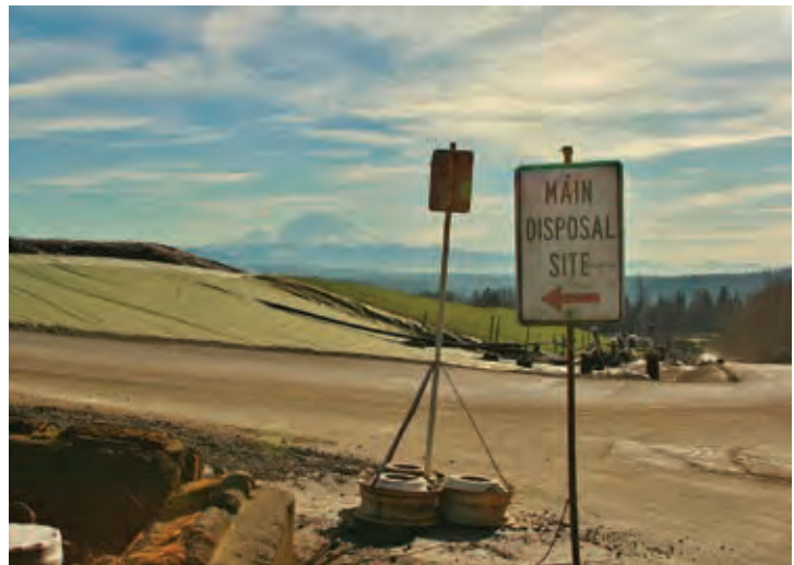
Cedar Hills Regional Landfill
