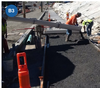
B3. Pouring concrete sidewalk
