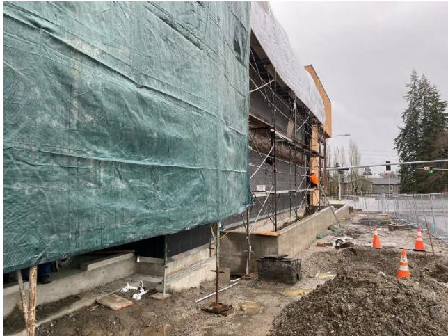
Finishes E1 West Side
