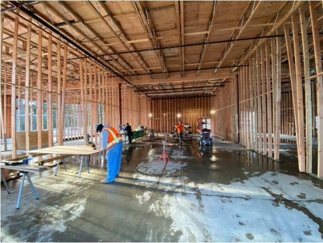
MEP Rough in E1
